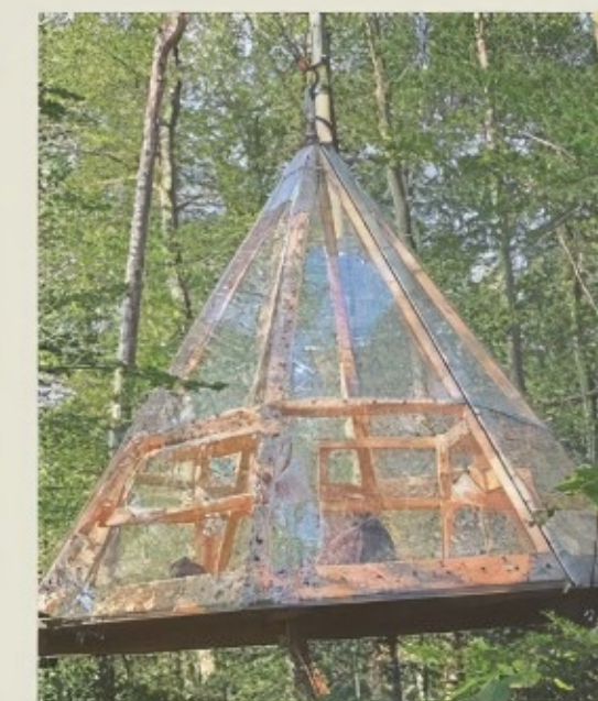
Das Baumhaus Birkenfeld kann frei schwingen dank der Befestigung mit Stahlseilen, die an eine Gondelbahn erinnern. ARCHIVFOTO: SVV BIRKENFELD
